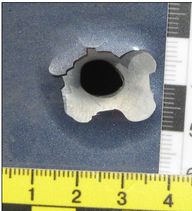
Пошкодження на металі.
