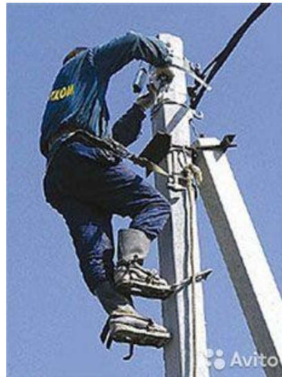
Електромонтанжні «кігті» та спеціальний пасок для підняття на електроопору
