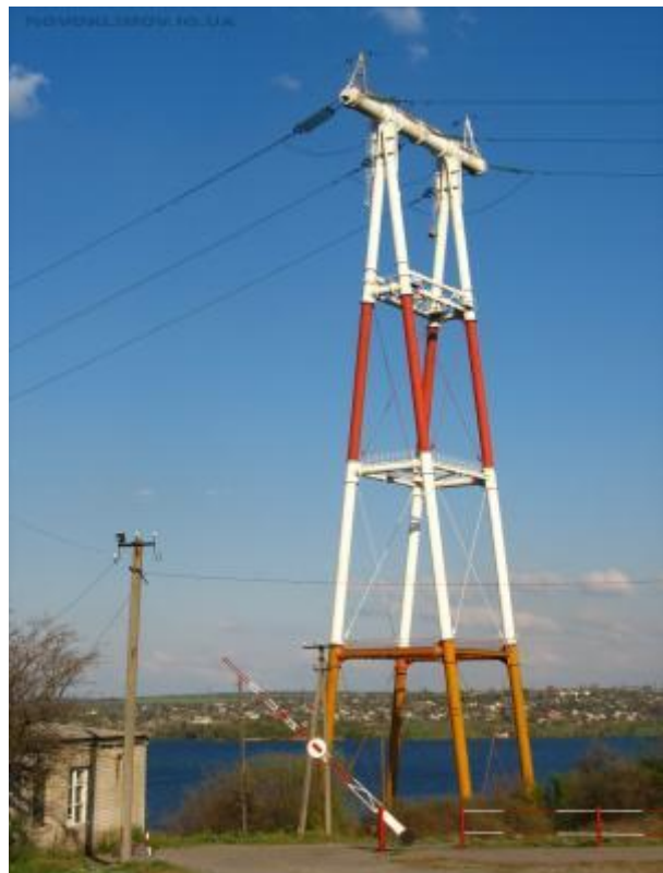
АП-подібна трубчатата опора ЛЕП
