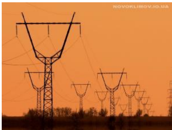
Y-подібна опора ЛЕП «чарка»
