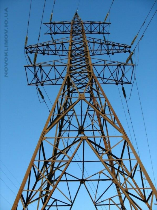
Анкерна металева опора баштового типу
