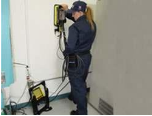
Кабелі та датчики, вбудовані в стіни
