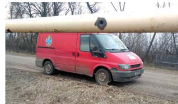
Рис. 4. Зруйнований внаслідок обстрілу з боку збройних формувань РФ газопровід в районі н.п. Новолуганське [23].
